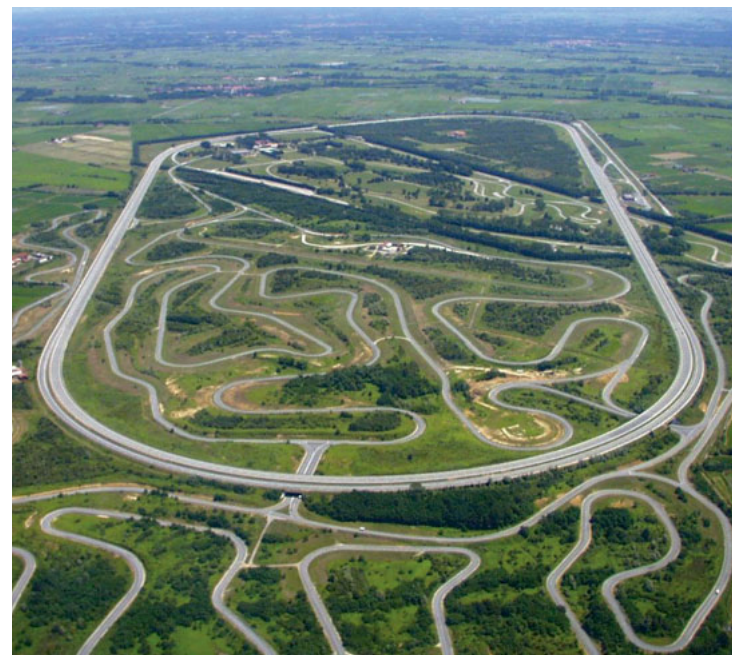
Balocco Proving Ground zwischen Mailand und Turin - eines der grössten Testgelände der Welt.
